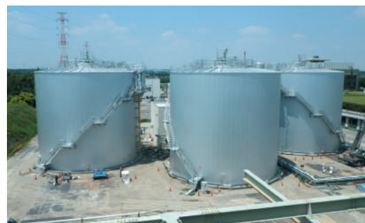
現地組タンク(消化槽)
